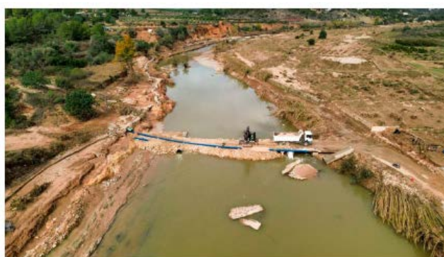
Imagen 14: Trabajos de reparación provisional de tubería de 300 mm sobre rio Magro. Fase 0
