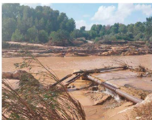
Imagen 7: Vista del paso inundable sobre el río Magro tras la DANA
